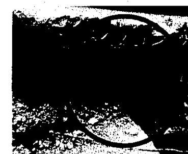
13: Zoom con dettaglio cavi non segnalati, ed esposti
